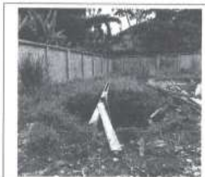
Imagen n.º 2 se observa una excavación para la ejecución de pozo percolador con la existencia de nivel freático a -0.60 del nivel terreno natural.
